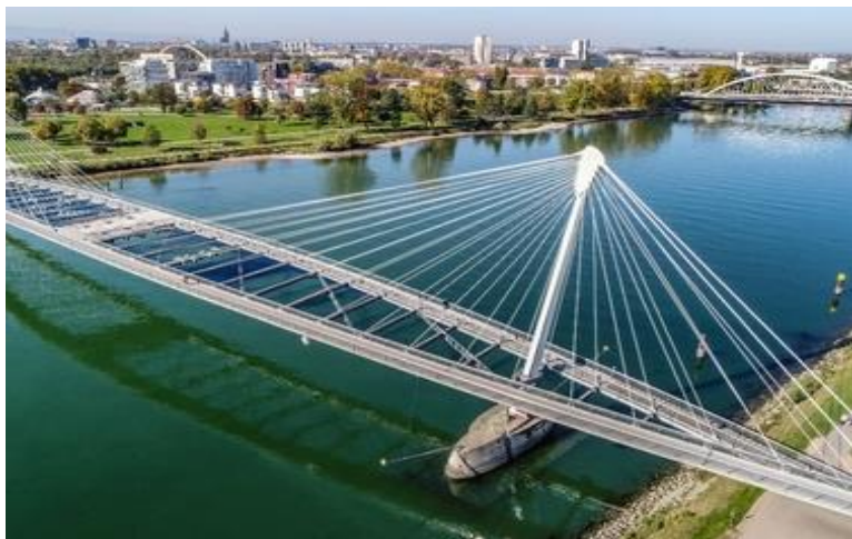
La passerelle des Deux-Rives entre Strasbourg et Kehl
